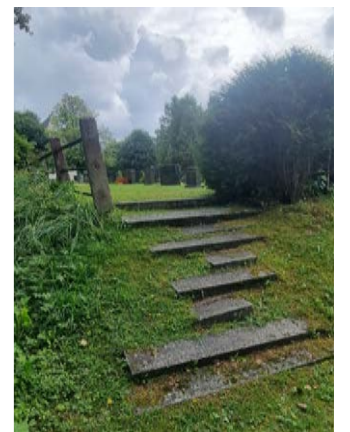
6. Smitväg med infällda trappsteg i sten. Grind saknas.
