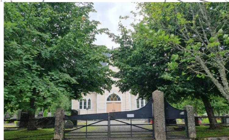
9. Smidesgrind från 1956, grindstolpar i granit
